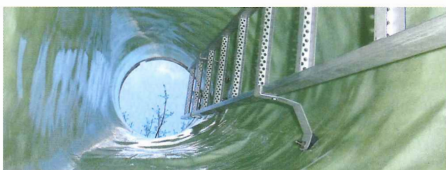
Sanovaná revizní šachta
