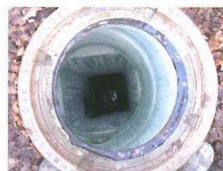
Realizace šachty s čtvercovým profilem
