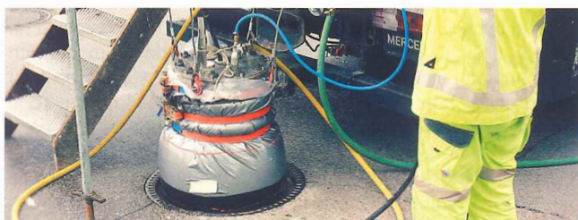
Proces natlakování rukávce a jeho vytvrzování UV zářením
