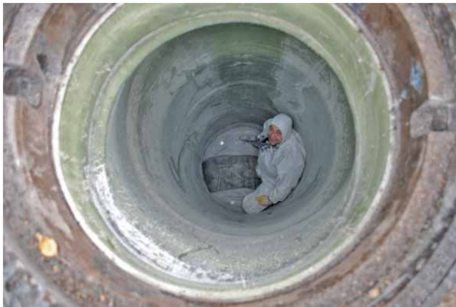
Die Schachtunterteile werden in Lüneburg mit Platten und Formteilen aus GFK ausgekleidet und an den Vertiliner anlaminiert.
