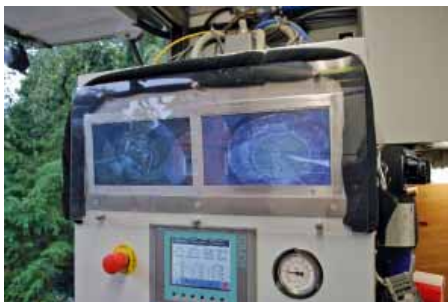
Der Aushärtvorgang wird elektronisch gesteuert und von zwei Kameras überwacht.
