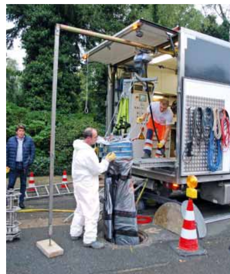
Einführen des Liners in den Schacht. Das Sanierungsfahrzeug wurde speziell für das Vertiliner-Verfahren aufgebaut.
