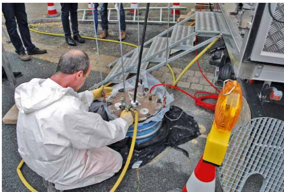
Exaktes Ausrichten und Positionieren des Liners.
