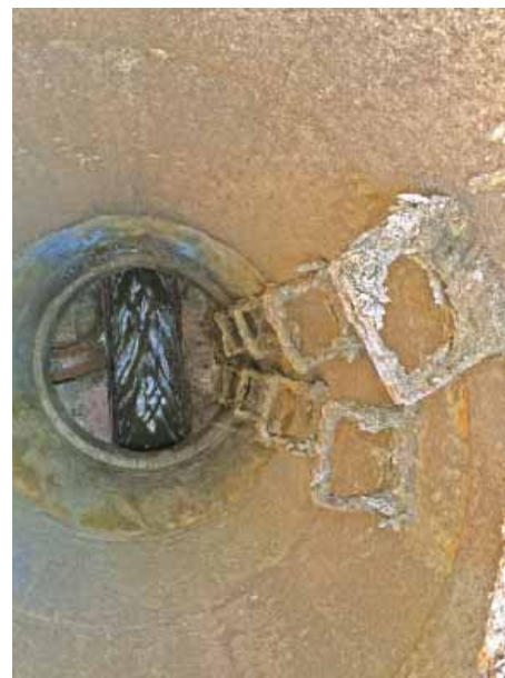
Blick in einen zu sanierenden Schacht.
