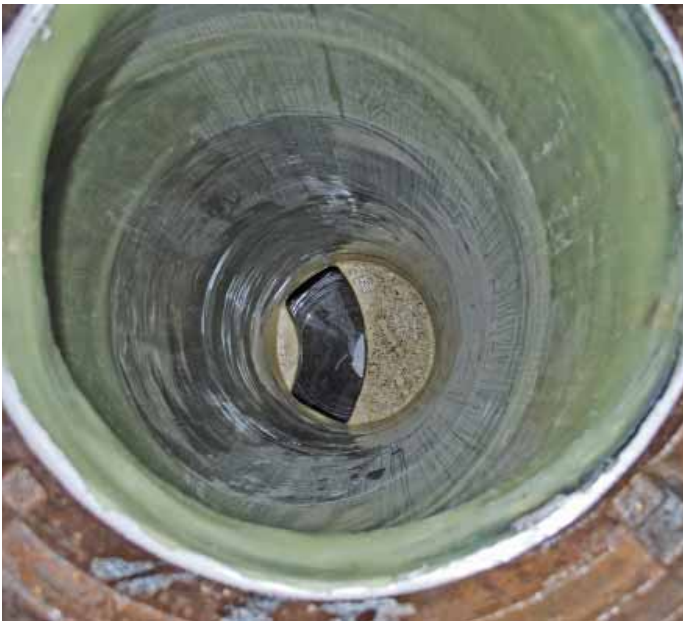
Überzeugendes Ergebnis: So sieht ein fertig sanierter Schacht aus.
