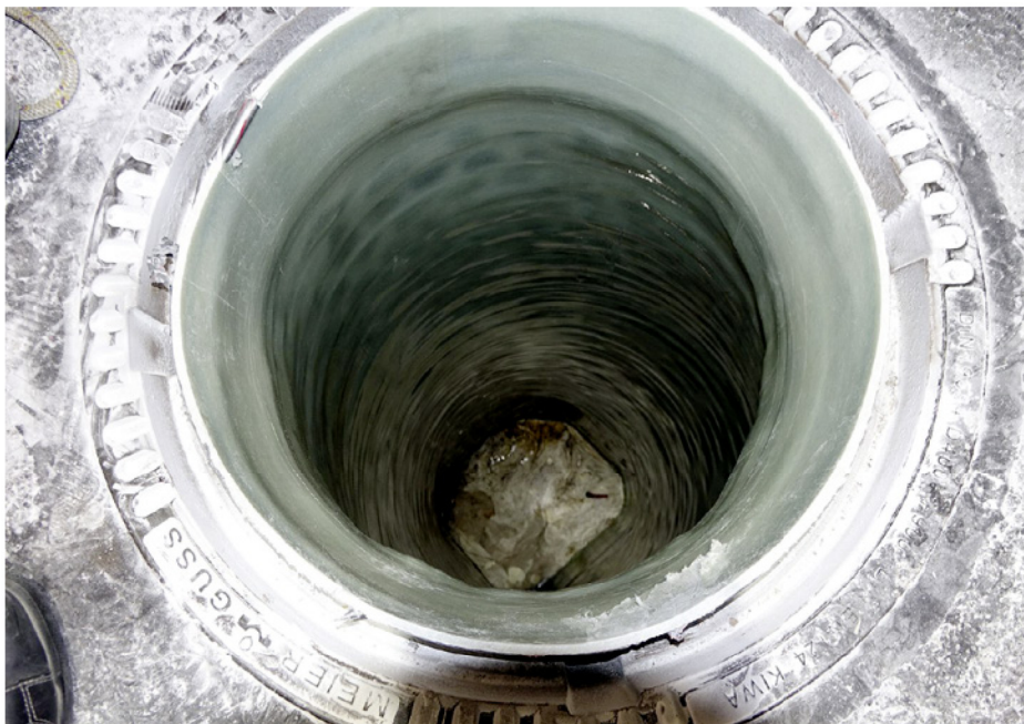
Das Ergebnis ist ein hochfest ausgehärteter und monolithischer Vertiliner. | Fotos: Diring & Scheidel Rohr-sanierung
