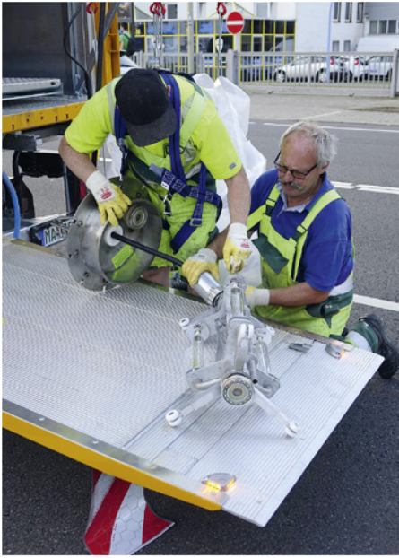
Die UV-Lichtquelle wird unterhalb der Abdeckung installiert.
