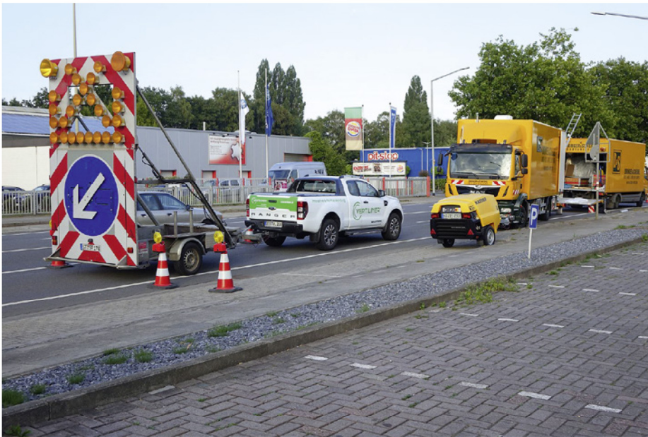
Für die Nachtbaustelle musste eine Spur der vierspurigen Pagenstecherstraße für einige Stunden gesperrt werden.
